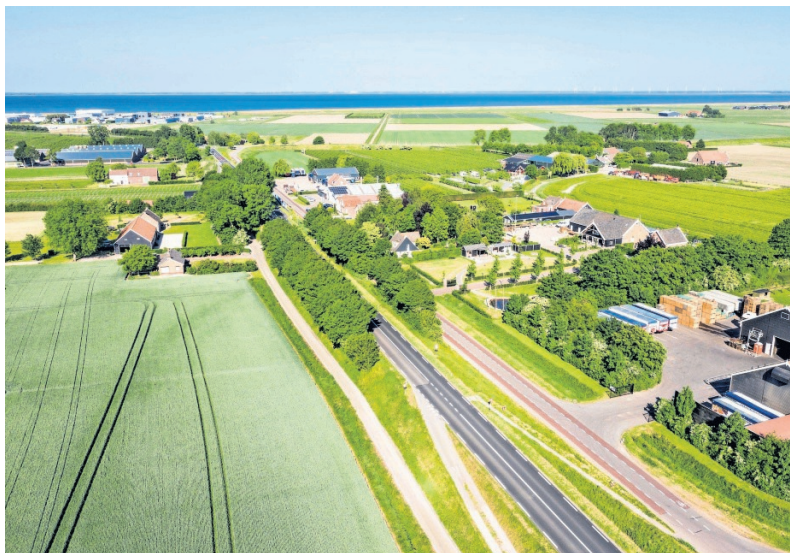
▲ Het gedeelte van de Zanddijk tussen Kruiningen en Yerseke dat op de nominatie staat voor verbreding. Als de provincie voor dit scenario kiest, zullen enkele huizen aan de noordzijde (links op de foto) moeten wijken. FOTO'S MARCELLE DAVIDSE
